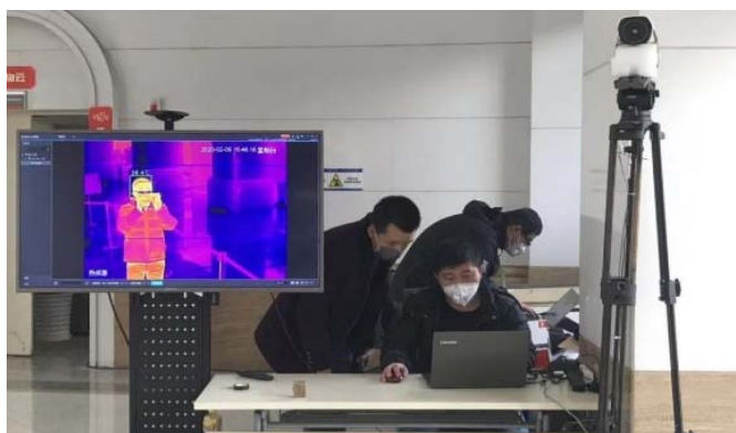
▲ 京东物流工程师正在为四川电信安装调试热成像监控系统
