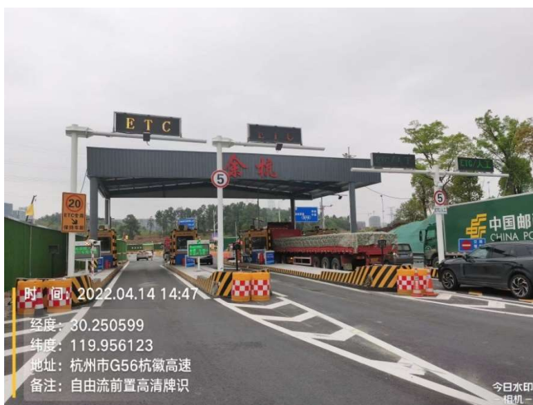
余杭收费站自由流车道
