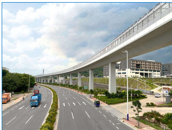
图 3 广州轨道交通十四号线 4x40m 全刚构梁桥建成效果
